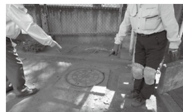
安全就業パトロール指導員と一緒に指差し呼称「マンホールの段差に踏いて転倒注意!」(渋谷区シルバー人材センター就業現場にて)
