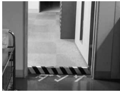
「危険の見える化」 就業現場に危険表示を行っている (北区シルバー人材センター)
